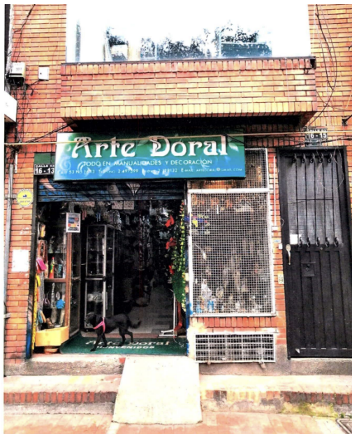
Foto actual octubre 12/2020 de fachada
